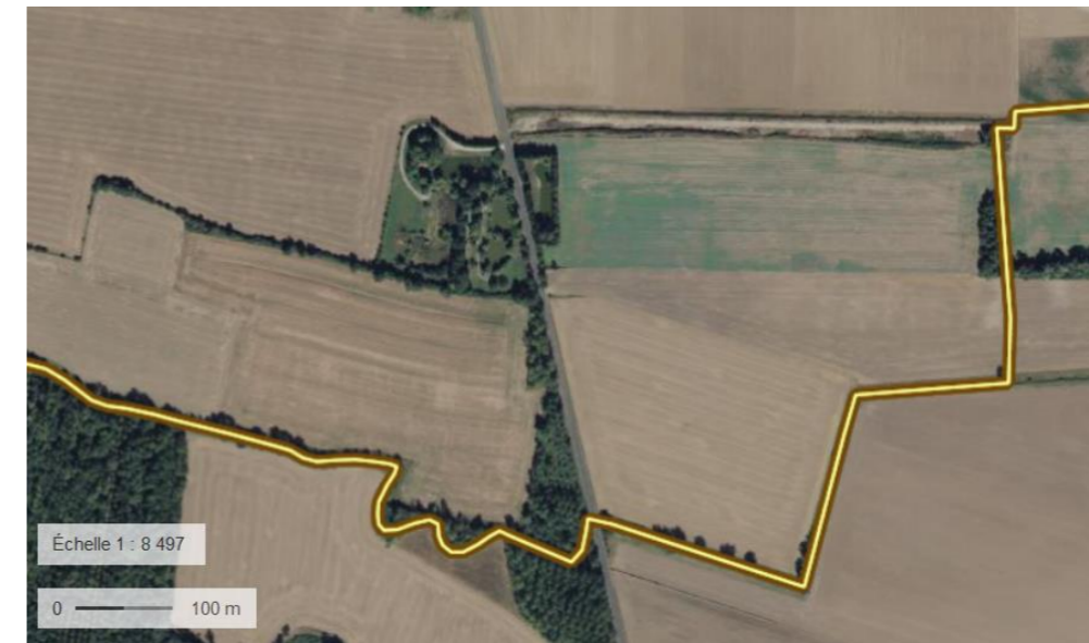
Figure 78 : Carrière sur Sogny-en-l'Angle après réaménagement agricole (AP du 13/09/2019)
