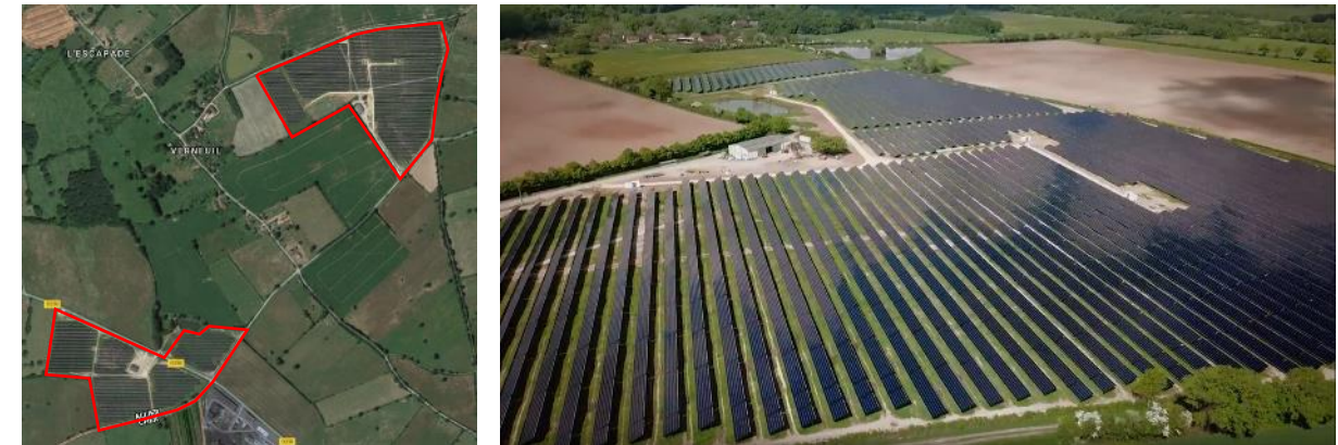
Figure 11 : Localisation des centrales photovoltaïques de Braize (03) développées par JPee
