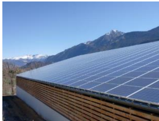
Figure 9 : Centrale photovoltaïque en toiture d'Embrun exploitée par JPee
