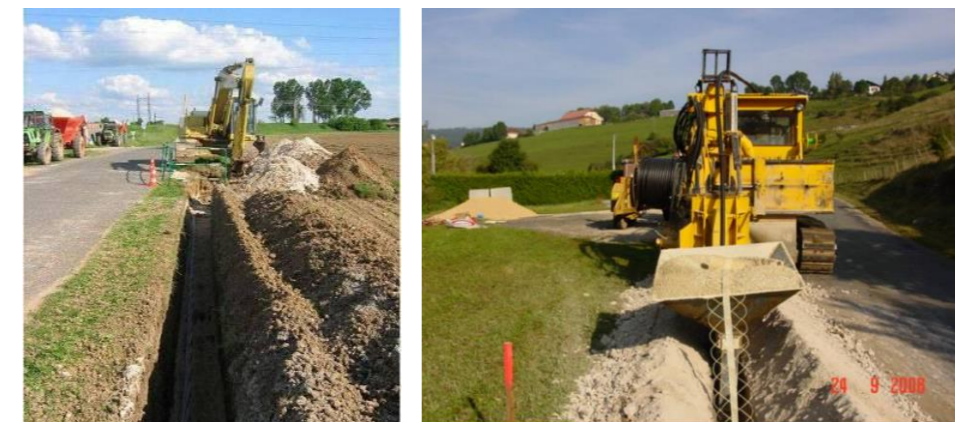
Figure 89 : Creusement d'une tranchée pour le passage de câbles électriques HT (Source : JPEE)
