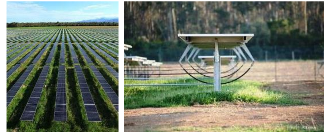
Figure 82 : Illustration de tables sur tracker mono-axe (Source : Exosun)
