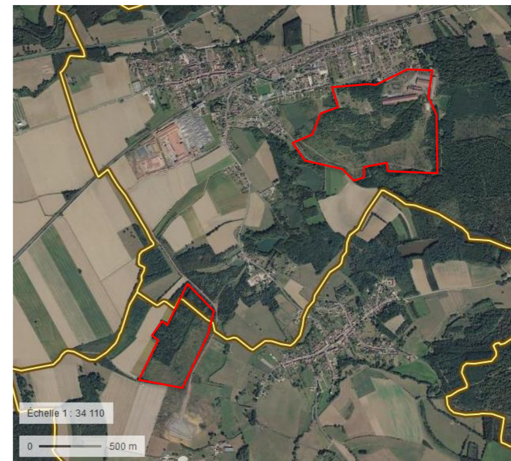
Figure 69 : Les deux projets de centrales photovoltaïques au sol de Pargny-sur-Saulx, en bas celui porté par SOLEIA 49
