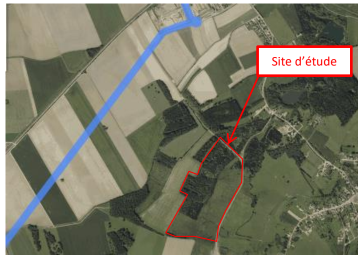
Figure 61 : Canalisation de transport de gaz naturel à proximité du site d'étude (Source : Géoportail)
