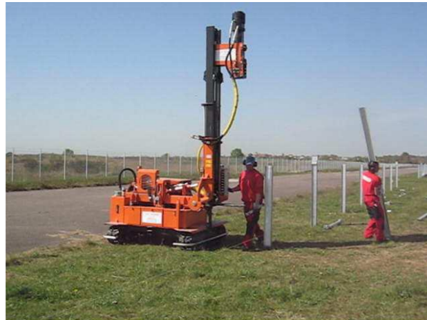
Figure 83 : Implantation de pieux battus
